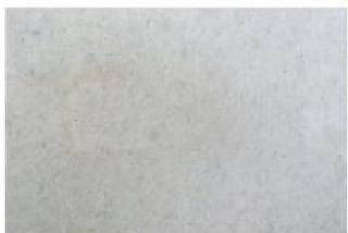
BETON LISSE BRUT
