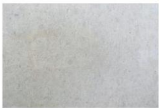
BETON LISSE BRUT
