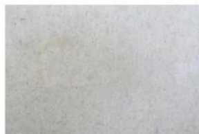
BETON LISSE BRUT
