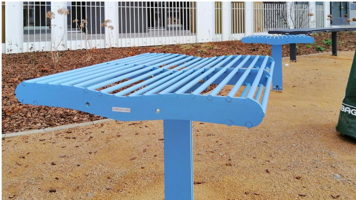
**Description** : Structure et assise en acier galvanisé. L'assise est composée de 22 tubes de 10mm de diamètre. L'assise est soudée sur un pied.
