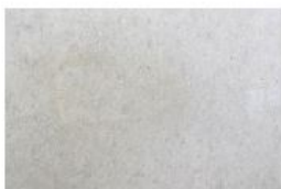
BETON LISSE BRUT
