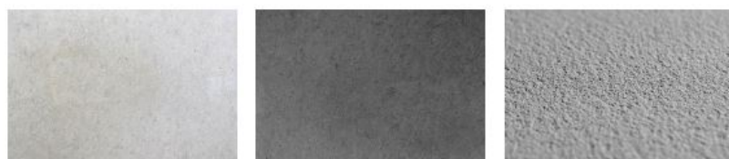
BETON LISSE BRUT
