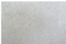
BETON LISSE BRUT
