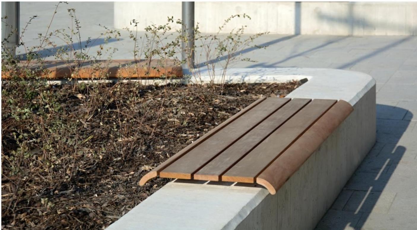
**Description :** La structure est composée de tiges d'acier fermement ancrées dans la fondation en béton avec des boulons en acier vissés aux tiges. L'assise est composée de 5 planches en bois de : Chêne, Pin ou Bois Tropical. Les planches de bois sont assemblées à la structure par des boulons en acier inoxydable.
