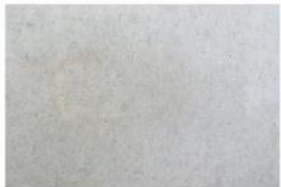
BETON LISSE BRUT
