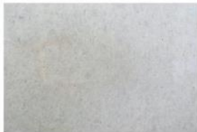
BETON LISSE BRUT
