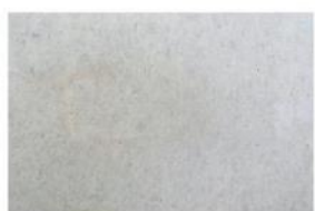
BETON LISSE BRUT
