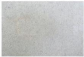
BETON LISSE BRUT
